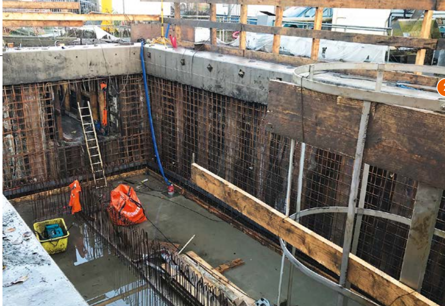
1 — Travaux de couverture du stockage de Montredon.
