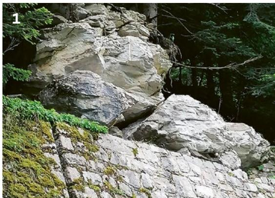
**Image 1** — Blocs s'étant propagés jusqu'en tête du mur de soutènement qui surplombe la route à Artouste. ©BRGM
