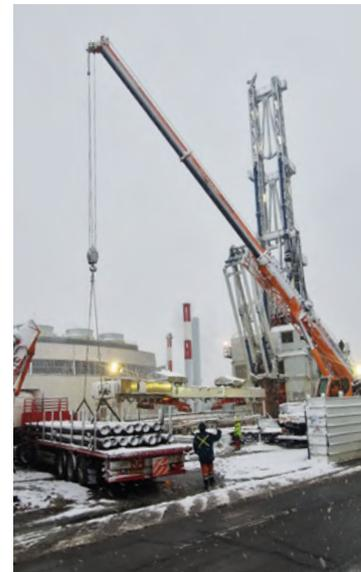
Forage pour l'installation de doublets géothermiques à Roissy.
